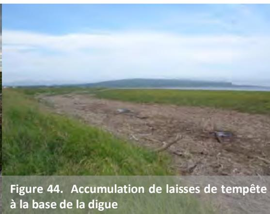
Figure 44. Accumulation de laisses de tempête à la base de la digue
