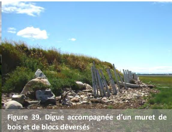
Figure 39. Digue accompagnée d'un muret de bois et de blocs déversés
