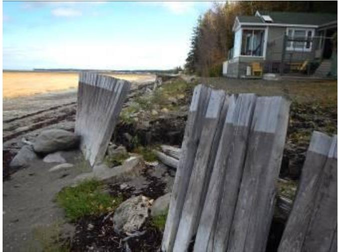
Figure 18. Muret de bois sévèrement endommagé
