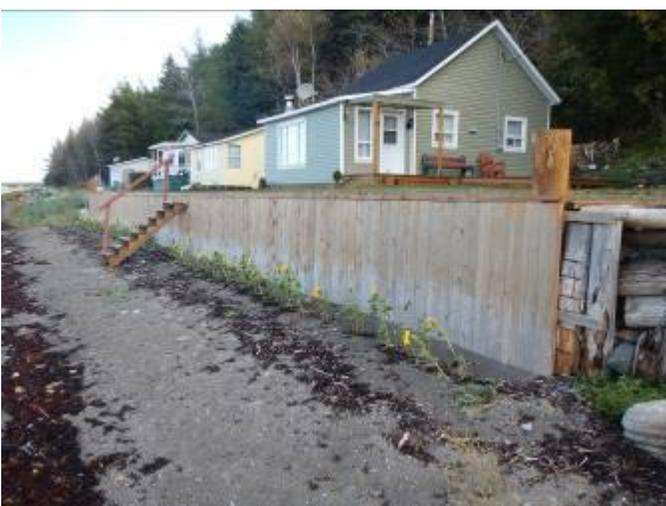
Figure 11. Côte artificielle composée d'un muret de bois
