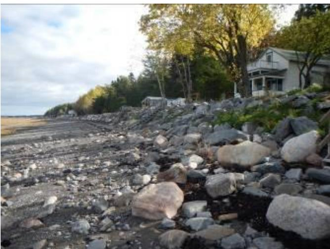
Figure 17. Affaissement d'enrochement et blocs sur la plage
