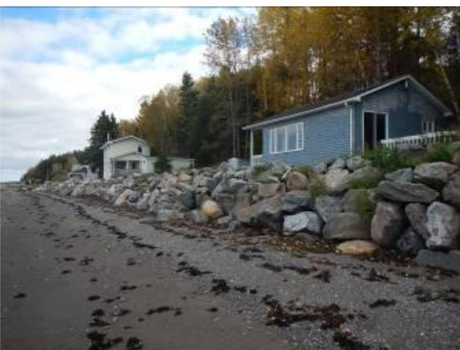
Figure 10. Côte artificielle composé d'un enrochement
